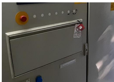
Selector 'Giro Parada' en posición de bloqueo de giro de góndola. 'Giro Parada' selector blocking the yaw system
