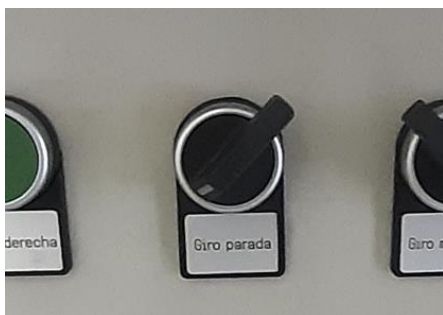
Selector 'Giro Parada' en posición de bloqueo de giro de góndola. 'Giro Parada' selector blocking the yaw system
